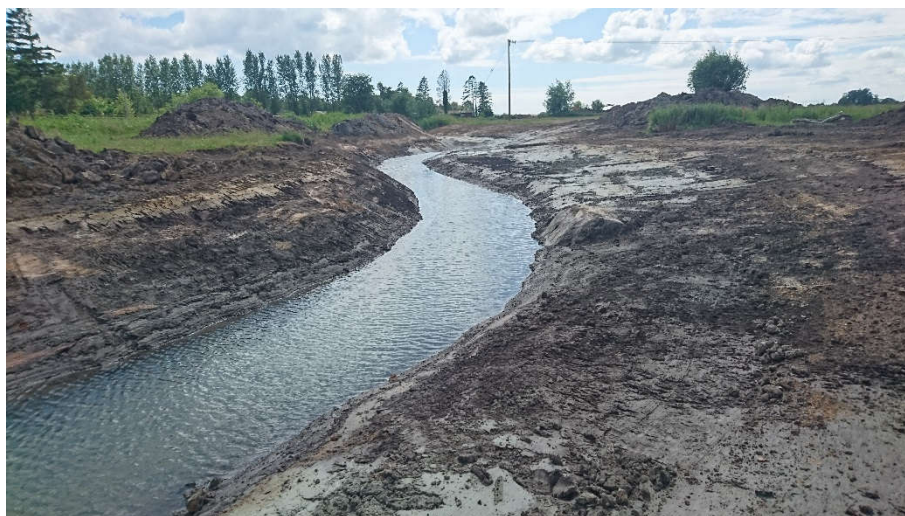
Anläggning av meandring i Tullstorpsån
