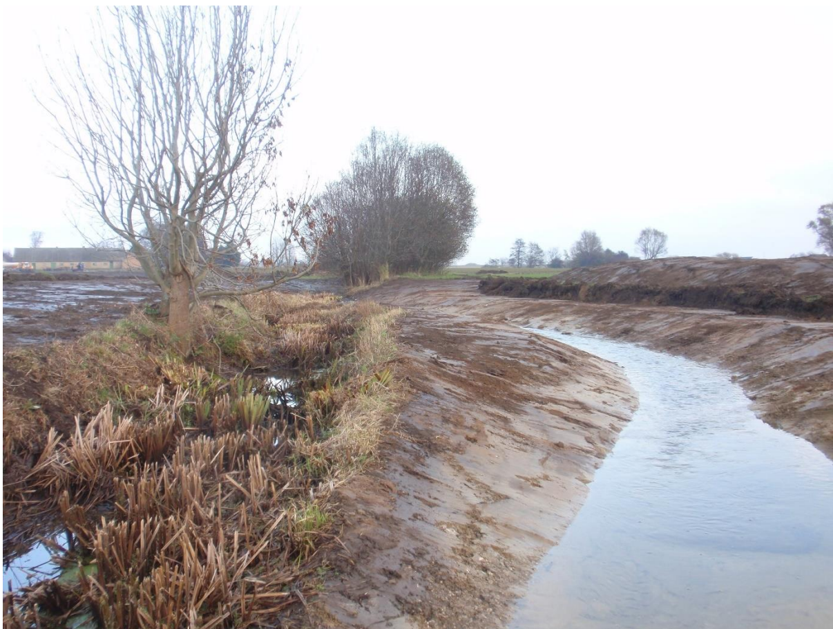
Ståstorpsån efter restaurering: Parti med kantavplanad och återmeandrad fåra till höger i bild samt gamla uträtade fåran till vänster.
