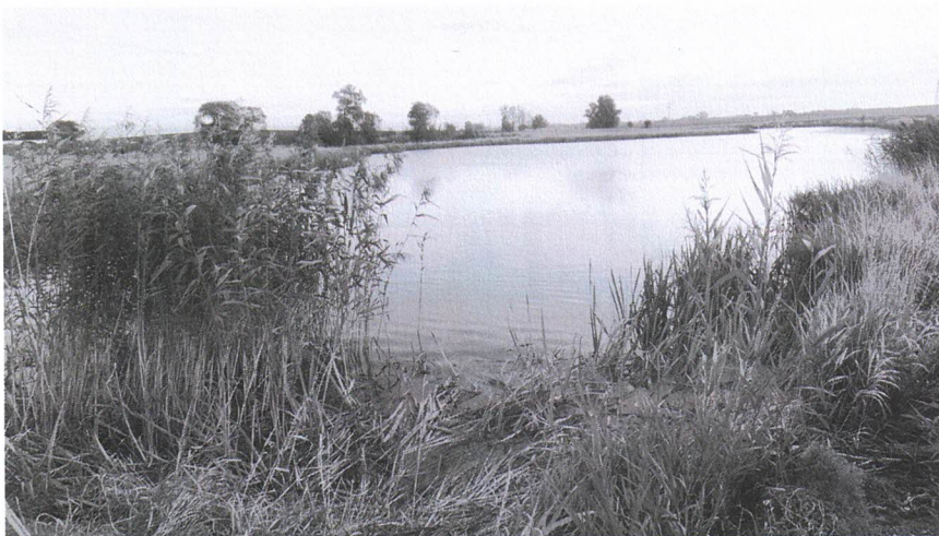
Foto 8. Damm nr 2 i Åmossarna.
