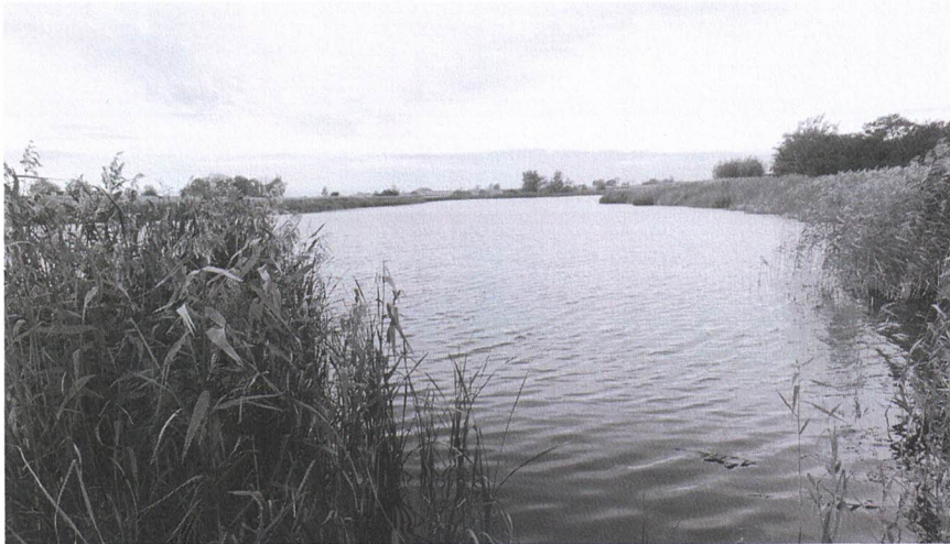
Foto 7. Damm nr 1 i Åmossarna.
